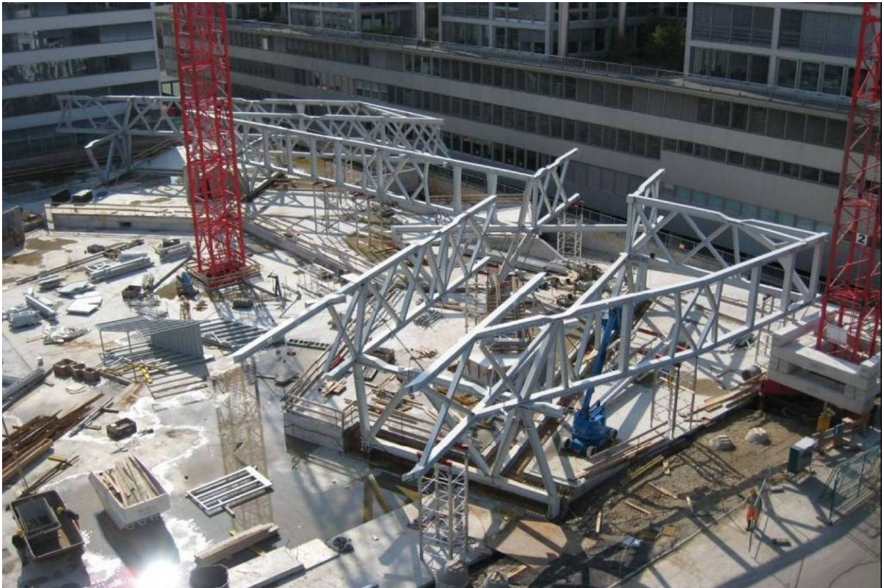
Bild 4: Umsetzung der Planung auf der Baustelle
