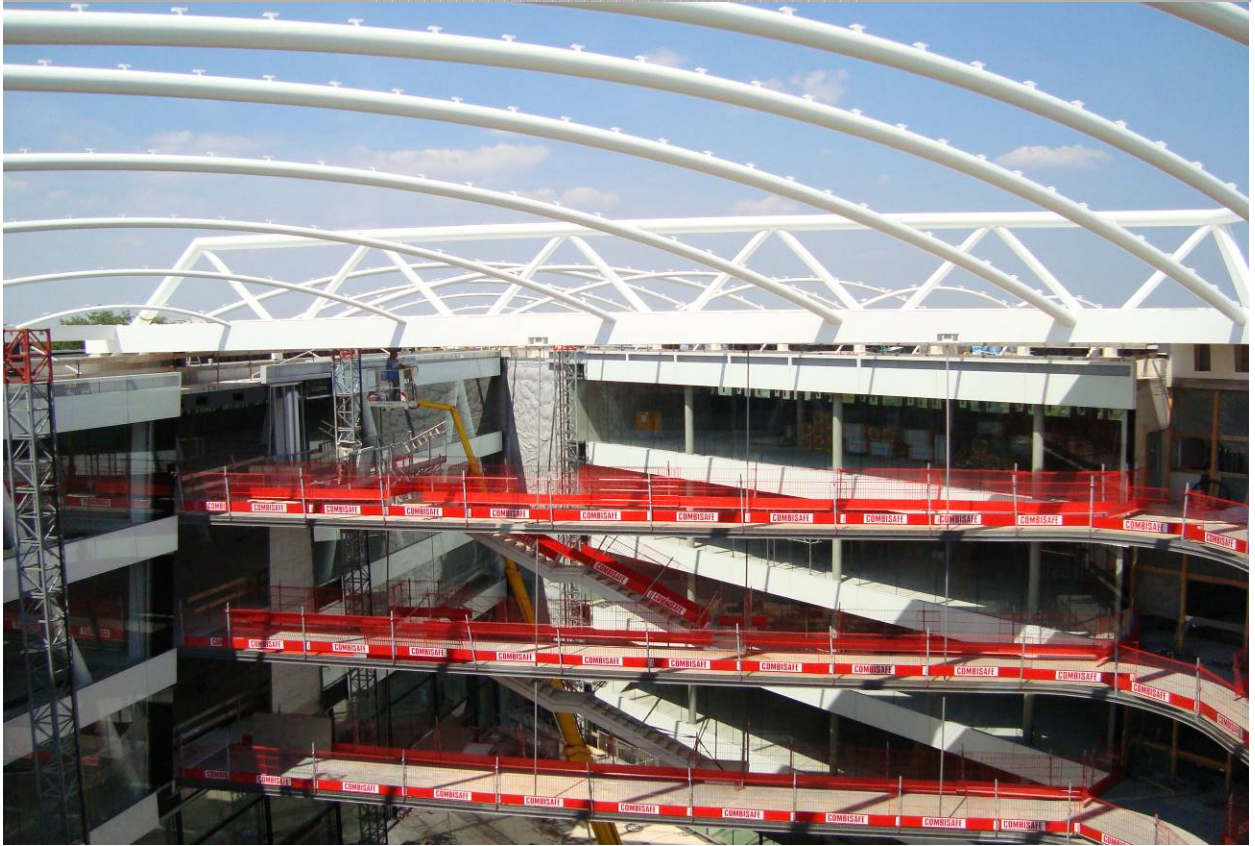
Bild 6: Umsetzung der Planung auf der Baustelle , PSS
