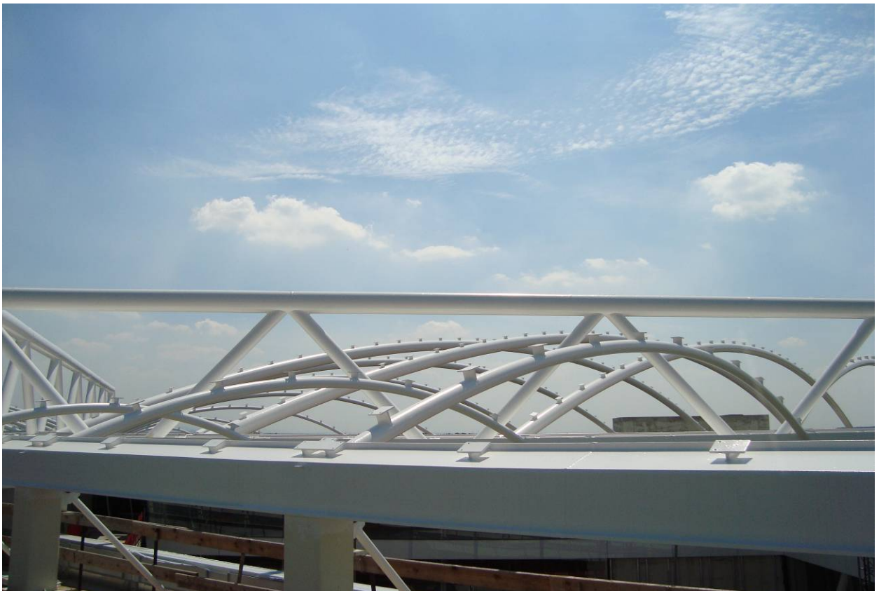
Bild 7: anspruchsvolle Architektur erfordert eine anspruchsvolle Planung , PSS
