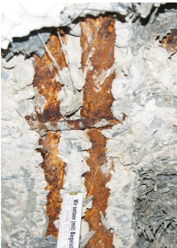
Sanierung des Sargdeckels mit Spritzbeton
