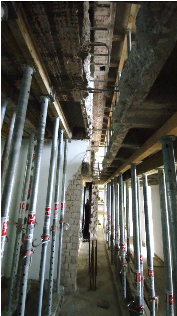
Einbau einer neuen Abfangung
