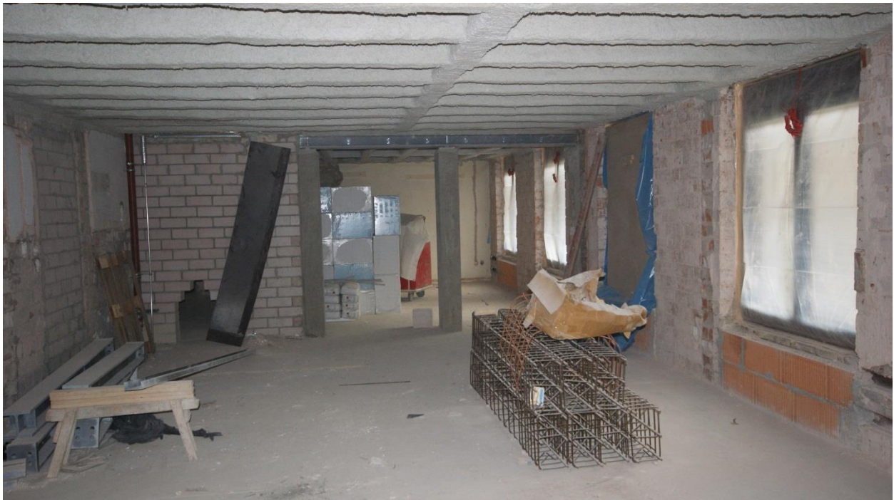
Brandschutzanierung in den Geschossen
